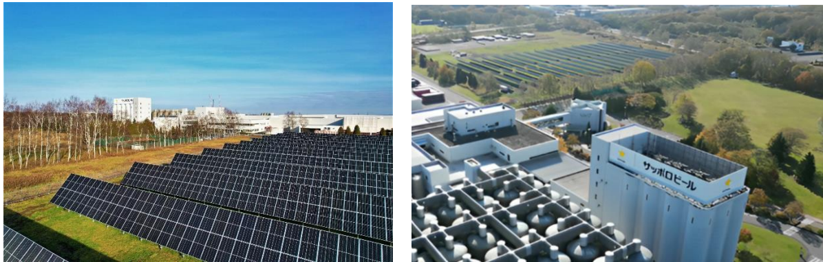
設備設置工事中の北海道工場
